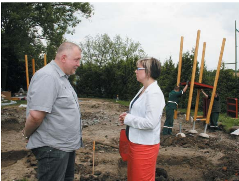
Místostarostka Petra Bernfeldová kontrolovala spolu s šéfem technických služeb Petrem Smoleněm instalaci nových herních prvků.
